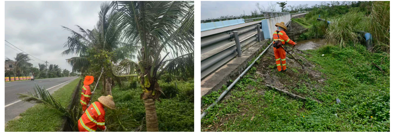
日常公路绿化养护作业
