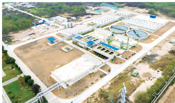
中水站提标减排技术项目
