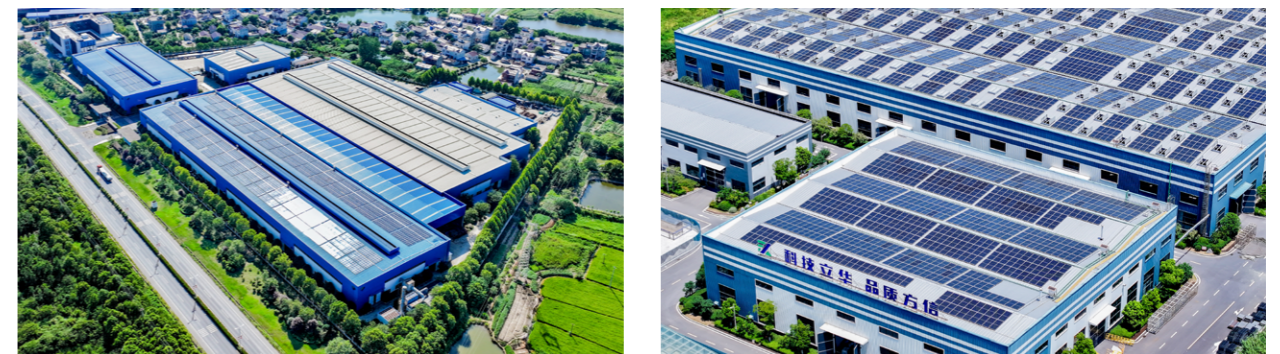
公司厂部屋顶分布式光伏项目
