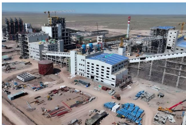
哈萨克斯坦江布尔州年产 50 万吨纯碱厂项目顺利转入安装攻坚阶段
